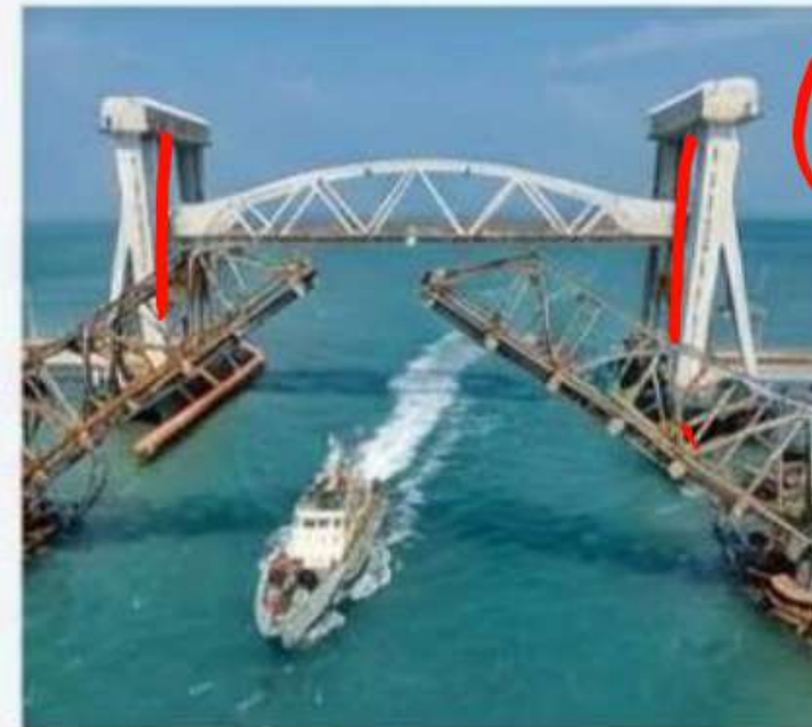
Pamban Bridge / पंबन ब्रिज
